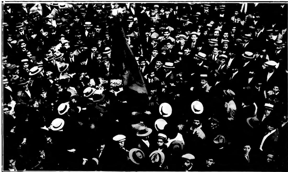
O enterro do operario hespanhol Francisco Martinez, morto num dos primeiros conflictos que se deram, por occasião das agitações verificadas nesta capital. Esta photographia foi tirada para "A Cigarra," no momento em que a enorme massa de grevistas conduzia o corpo pela rua Quinze de Novembro, a caminho do Cemiterio.
