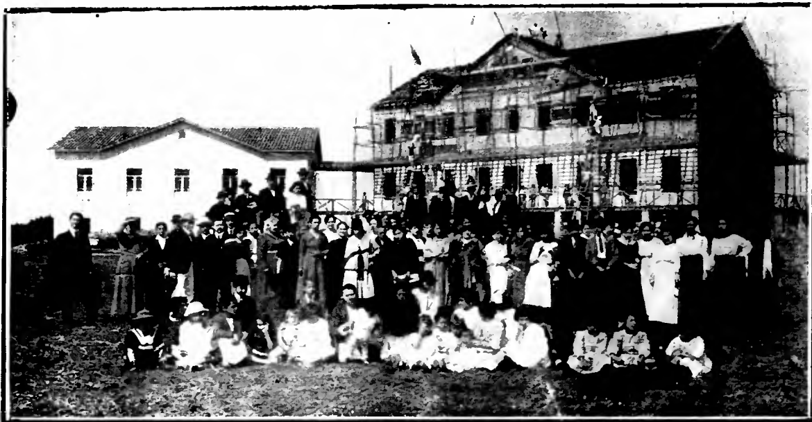
Photographia tirada para "A Cigarra" por ocasião da cobertura do pavilhão central (o segundo em construção) do Sanatório para Alienados, que a Sinagoga Ispirita S. Pedro e S. Paulo está construindo na estação de Gopouva, ramal de Guarulhos, em sitio alto e saudavel, de onde se descortina o panorama da capital. Os dois pavilhões comportam 240 doentes, e a directoria conta inaugurar em Dezembro proximo. O pavilhão central terá salão para musica, leitura, jogos e no parque que o rodeia haverá tanque para natação, campo de tennis e outros sports.
