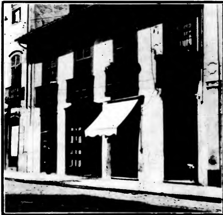
O palacio episcopal de D. Matheus, na rua do Carmo, donde saiu acompanhado do cabido, para receber sob o pallio, o príncipe D. Pedro, no dia 25 de Agosto de 1822.
