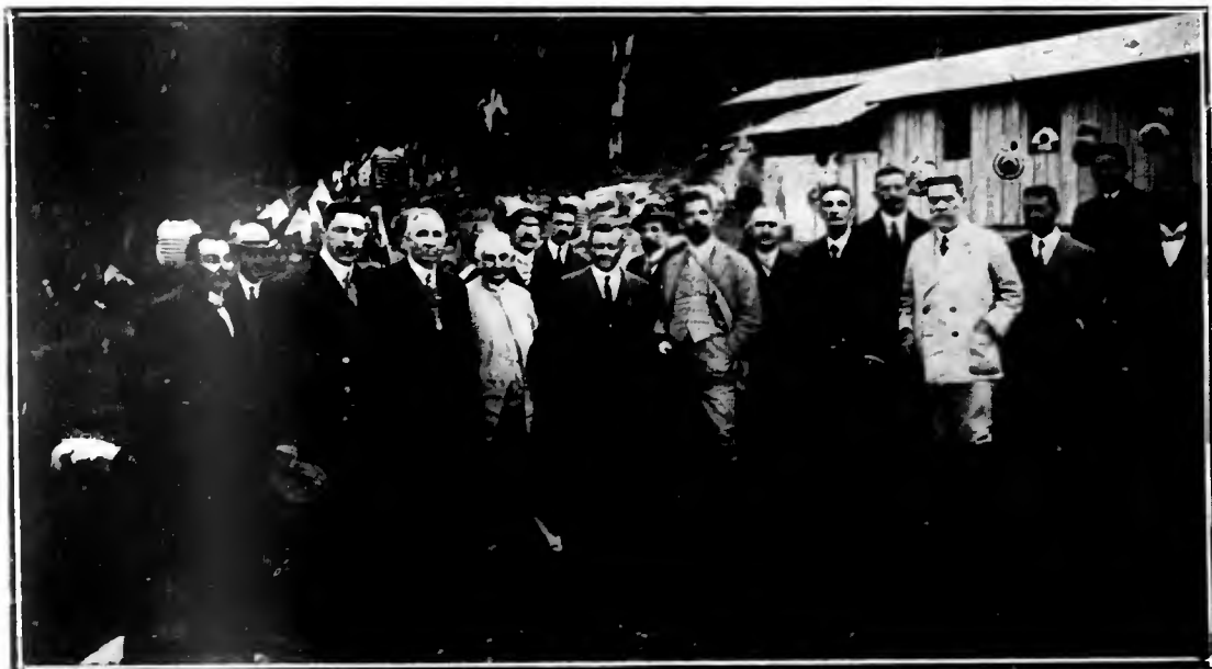
Visita da comissão de Fazenda da Camara dos Deputados ás obras da Estrada, percorrendo toda a linha
