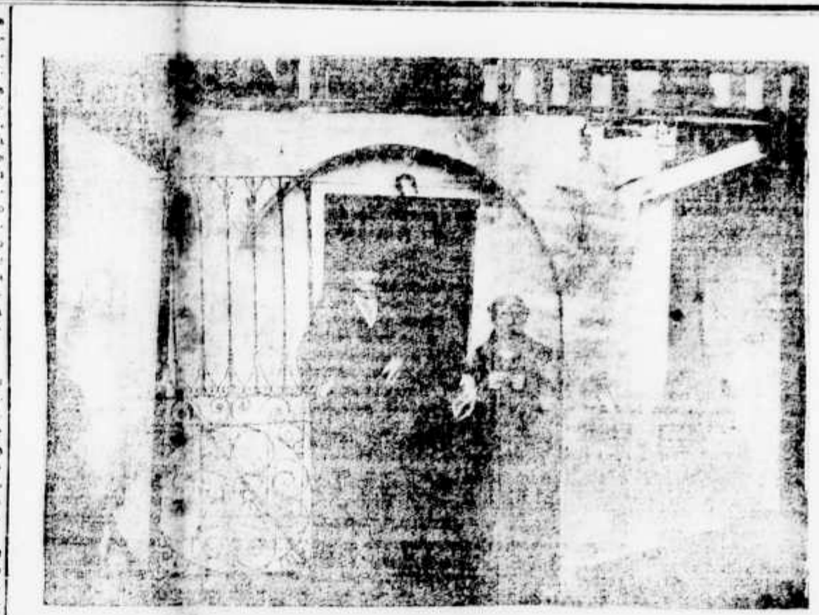
CORTIÇO DA RUA DE SANTA ROSA
