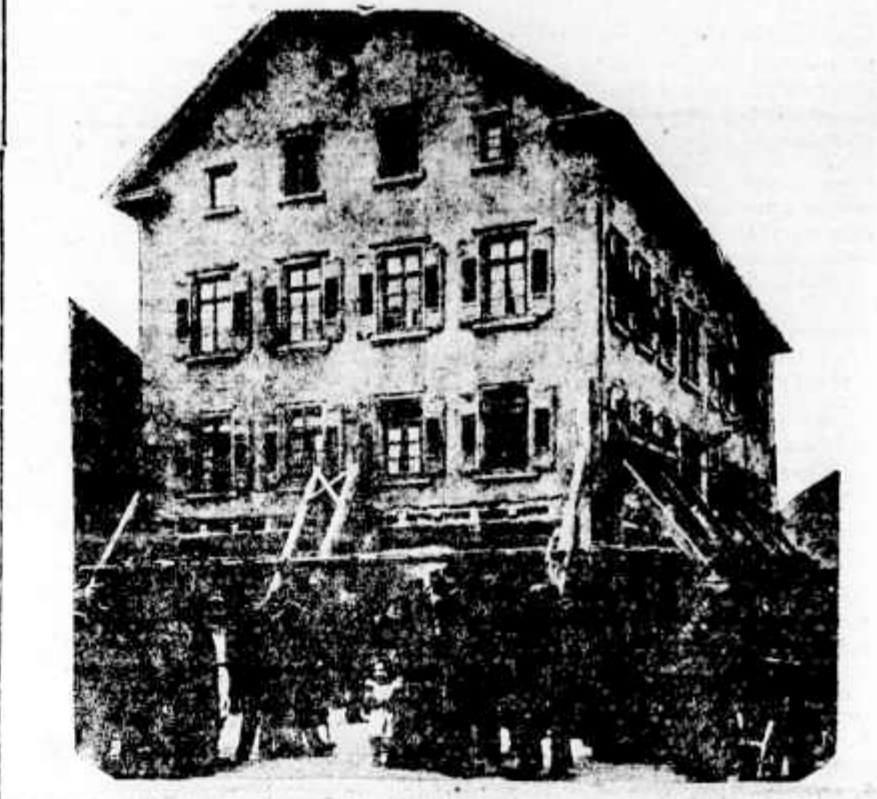
Hotel do Veado em Nagold (Wurtemberg) (A OBRA)
