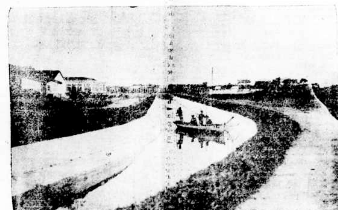
Obras do saneamento de Santos
