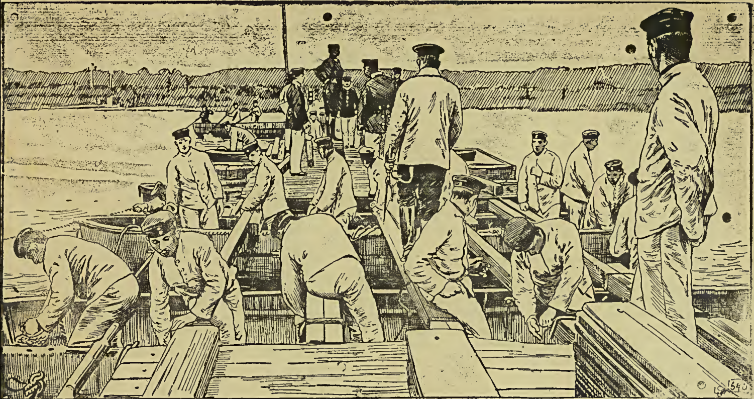
Eine besondere Versuchs-Pionier-Kompagnie, die aus sämtlichen 23 Bataillonen der Armee zusammengesetzt war, führt dieser Tage auf der Obersee bei Berlin einen interessanten Brückenbau aus. In Gegenwart des Kaisers wurde eine 220 Meter lange Pontonbrücke geschlagen und auch wieder abgebrochen.
