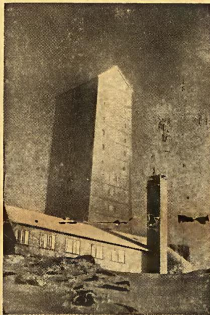
**Ein neuer Fernsender der deutschen Reichspost.** Auf dem Brocken im Harz (1142 m) wurde der neue Sendeturm der deutschen Reichspost fertiggestellt. Der Betonturm ist gegen die Witterungseinflüsse mit Holz verkleidet. Der Sendebetrieb wird im Frühjahr aufgenommen.
