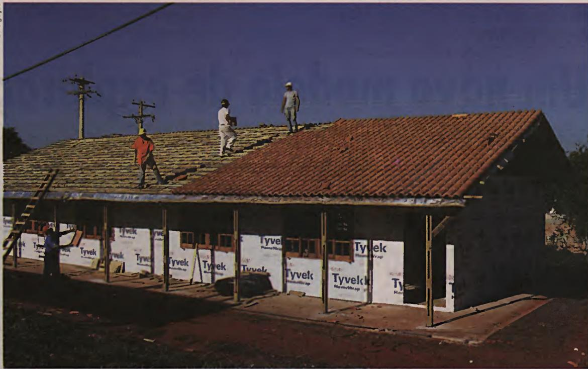
Construção na câmpus envolveu desde preparação da base de concreto até colocação das telhas e revestimento externo
