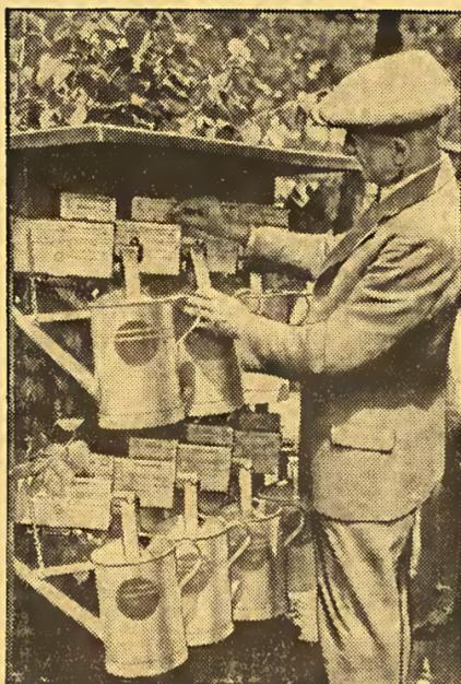
Aus der Werkstatt des Automaten-Erfinders: die Fünft-Pfennig-Giesskanne. — Der Automat gibt gegen Einwurf von 15 Pfennig eine Giesskanne frei. Wenn die Giesskanne wieder eingehängt wird, gibt der Automat 10 Pfennig zurück und behält die Leihgebühr von 5 Pfennig ein. — Der Automat erspart an einem Berliner Friedhof den Besuchern das lästige Mitbringen der Giesskannen.
